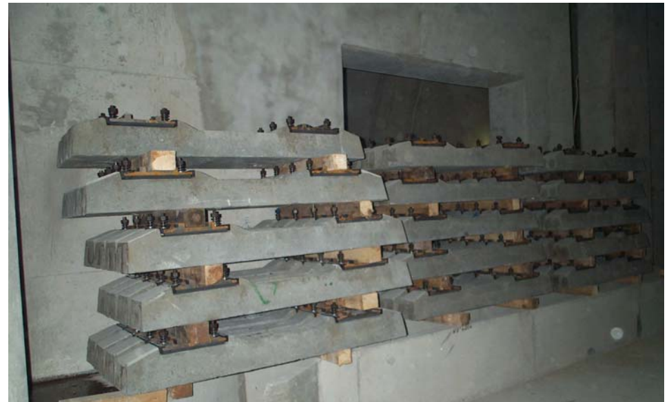
Im Tunnel verteilte Schwellen mit vormontierten RST - Stützpunkten (14.12.2004)
